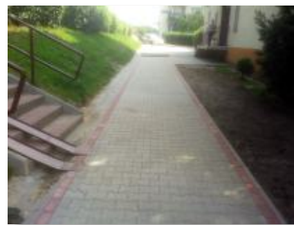
Wyremontowane chodniki ul. Krasickiego
