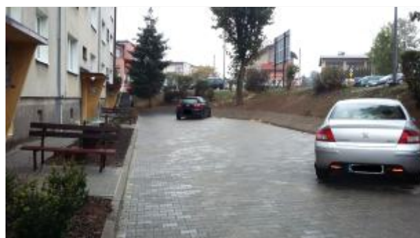
Nowa nawierzchnia ul. Poprzeczna 1-5
