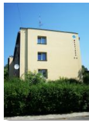
Docieplone ściany szczytowe ul. Morcinka 6-8
