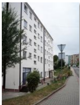
Odnowiona elewacja ul. Of. Faszyzmu 12-16
