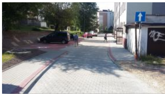
Nowa nawierzchnia ul. Wieczorka 1-9
