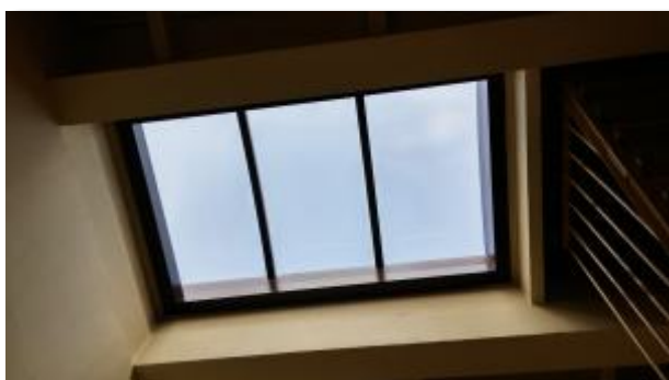
Nowe świetliki klatek schodowych ul. Zielona
